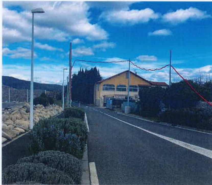
Figure 15 : Liaison passerelle - route d'Eus (en direction d'Eus)
