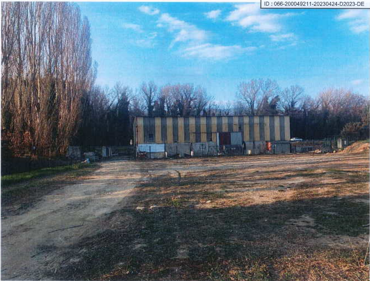
Figure 10 : Hangar communal et emprise du futur parc de stationnement perméable
